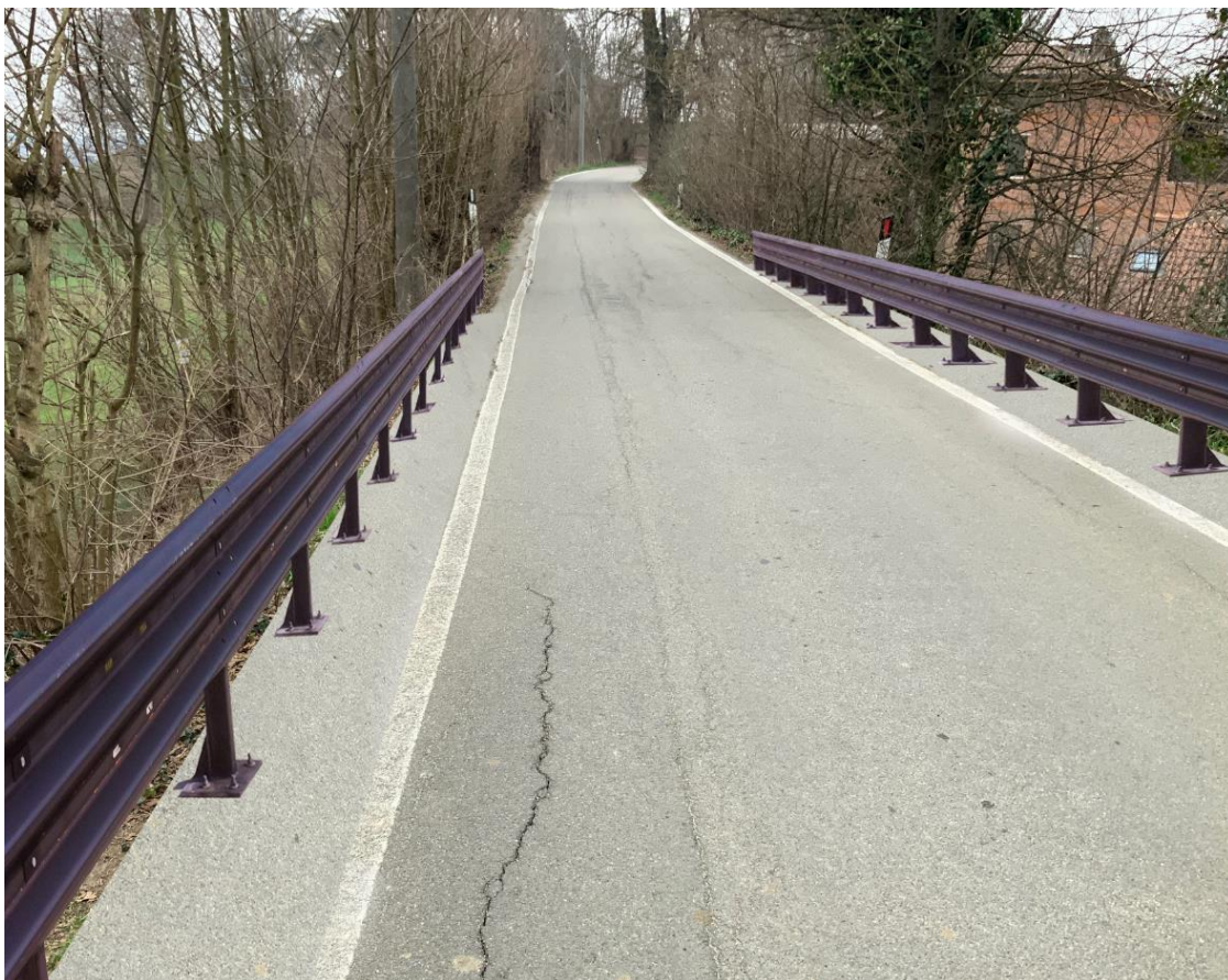
RENDERING Strato di progetto (cordolo con barriera stradale tripla onda, sviluppo 20+40 m)
